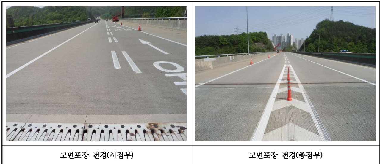
【사진 3.46】 교면포장 전경(울산)
