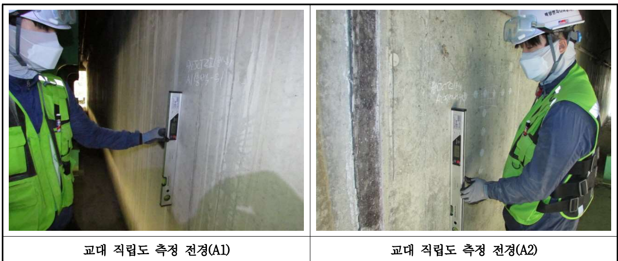
【사진 3.38】 교대 변위(직립도) 측정 전경(울산)
