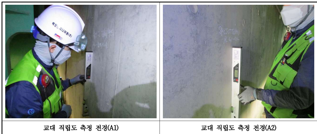
【사진 3.15】 교대 변위(직립도) 측정 모식도 및 측정전경 (부산)
