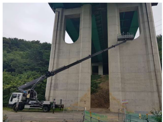
고소작업차를 이용한 현장조사
