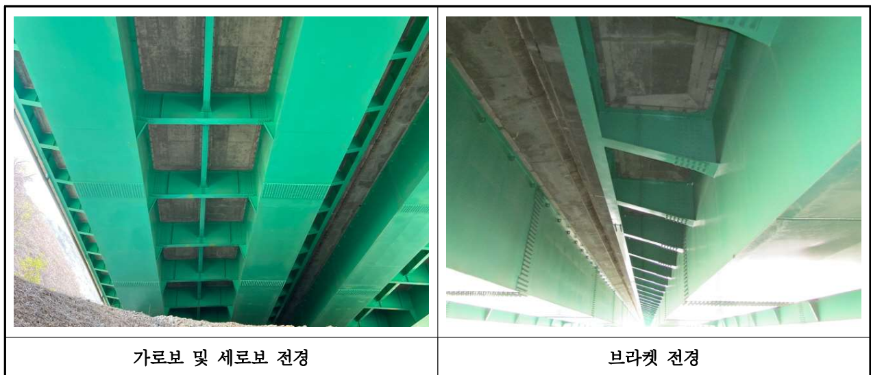
【사진 3.34】 2차부재(가로보, 세로보, 브라켓) 전경(울산)
