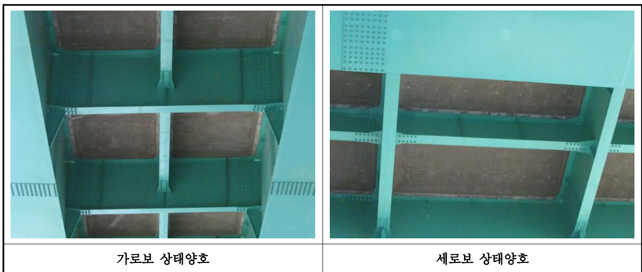
【사진 3.12】 2차부재(가로보, 세로보) 손상현황(부산)
