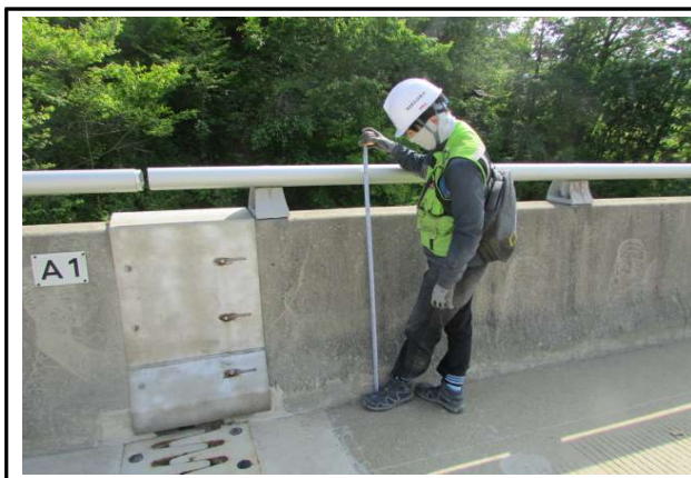
【사진 3.3】 부재제원 확인 전경
