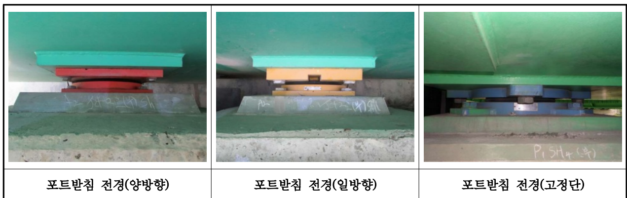
【사진 3.19】 교량받침 설치전경(부산)
