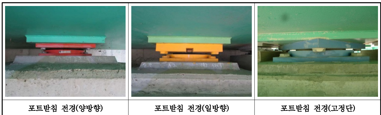
【사진 3.42】 교량받침 설치전경(울산)
