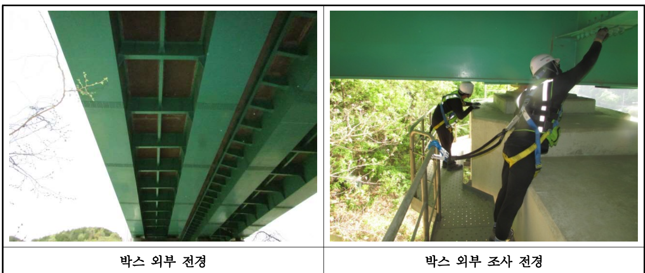
【사진 3.6】 강박스 거더 전경(부산)
