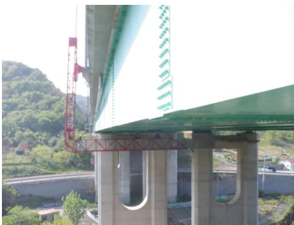
교량점검차를 이용한 현장조사
