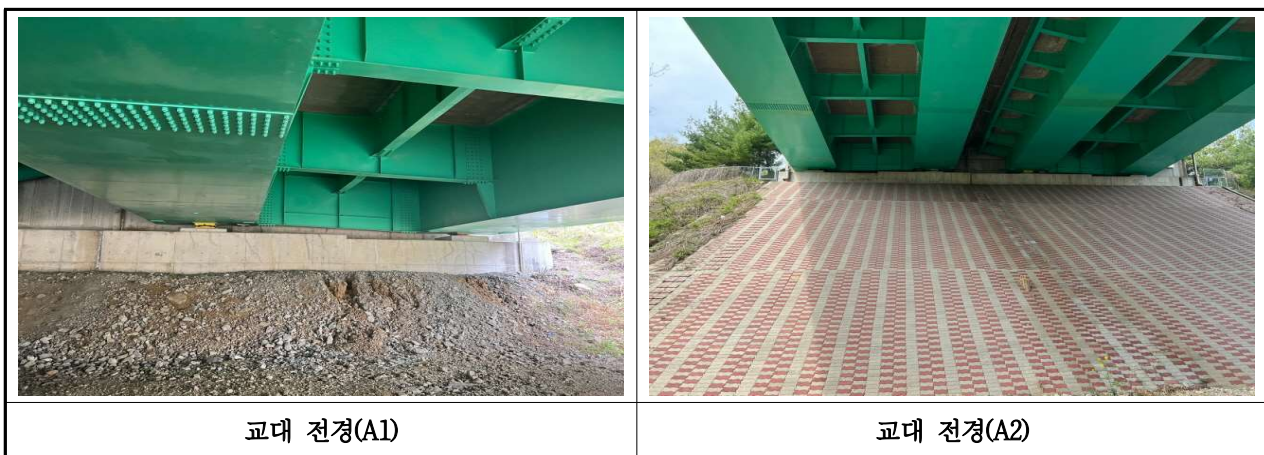
【사진 3.13】 교대 전경(부산)
