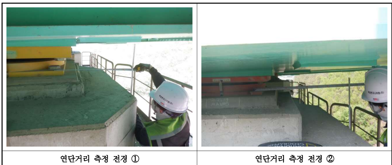
【사진 3.44】 연단거리 측정 전경(울산)
