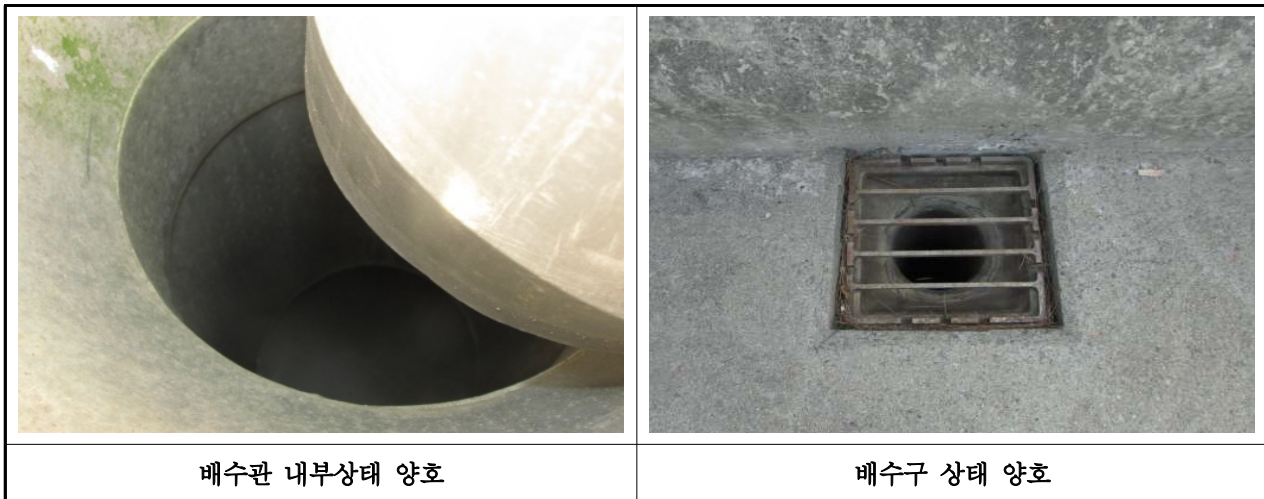
【사진 3.26】 배수시설 손상현황(부산)
