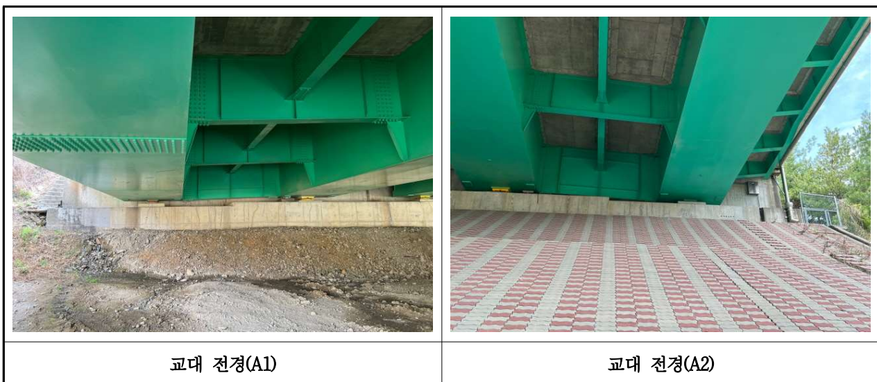
【사진 3.36】 교대 전경(울산)
