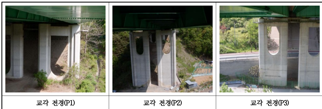
【사진 3.16】 교각 전경(부산)
