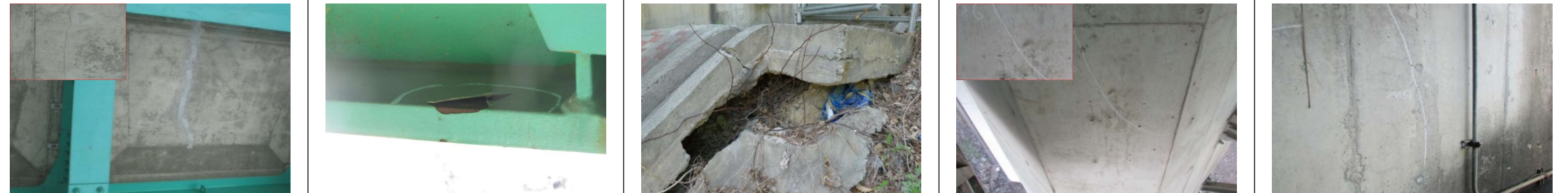
바닥판 S3 균열(Cw=0.3mm이상) 거더외부 S1-G1 도장박리 교대 A2 배수로 토사유실 교각 P1 코깅 균열(Cw=0.3mm이상) 교대 A1 홍벽 균열(Cw=0.2mm)
