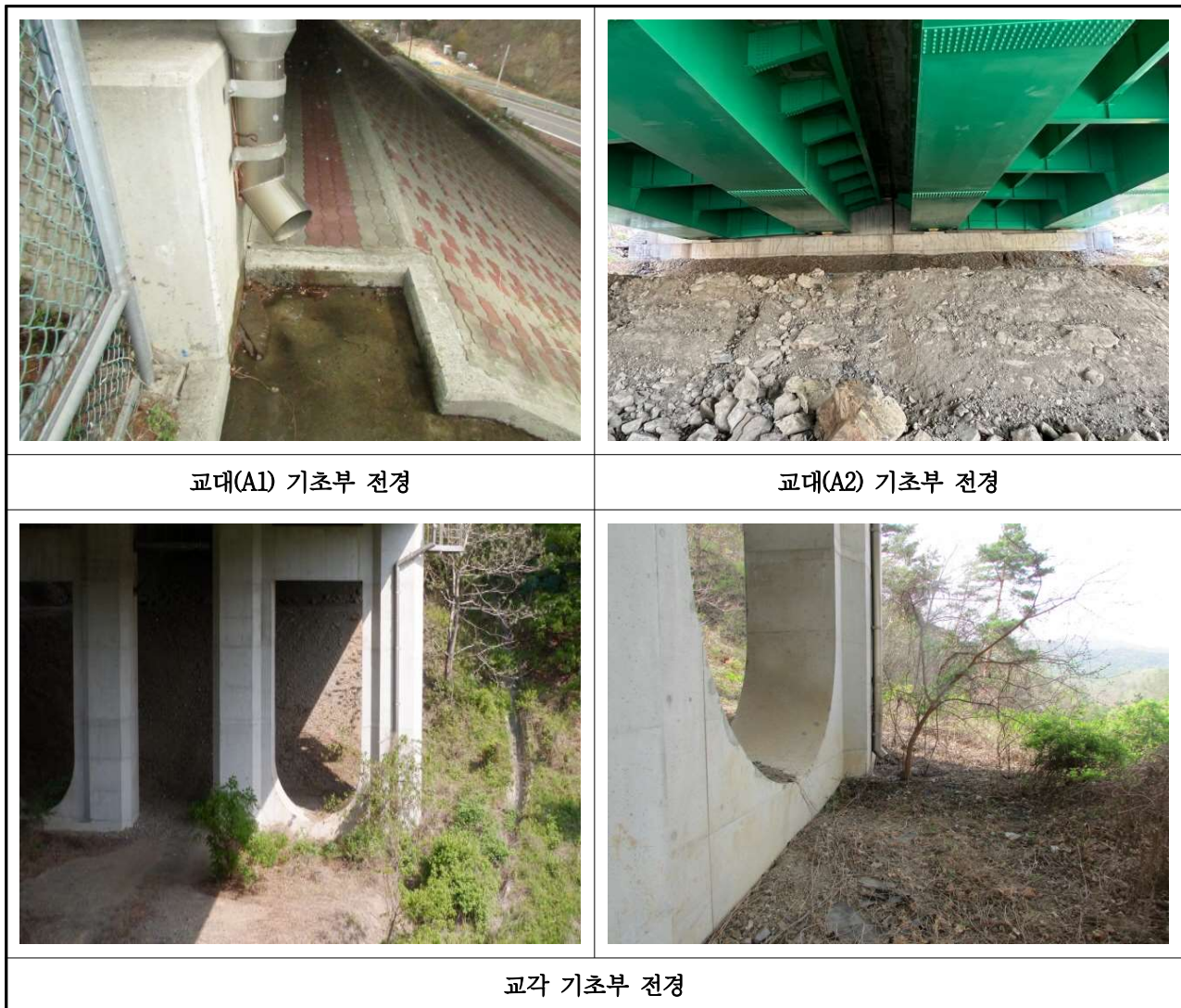
【사진 3.18】 기초부 외관조사 현황(부산)
